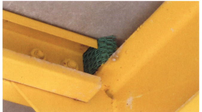
図2. ネズミの移動経路を金網で塞ぐ一例
