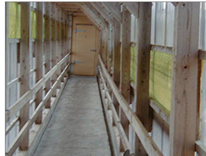
1. 舗装された屋根壁のある通路
